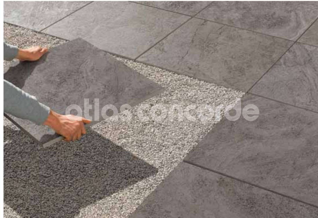
Укладка на гравий Onto gravel
